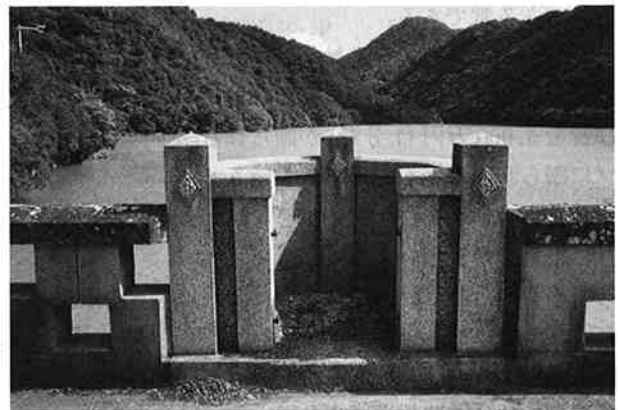
写真-4 中樋操作のための張り出し
