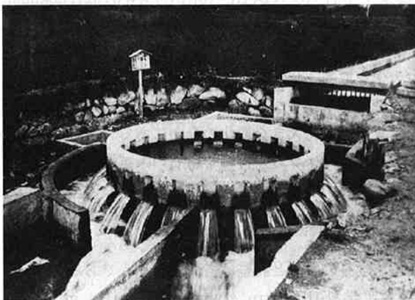
写真-1 建造直後の円筒分水工
